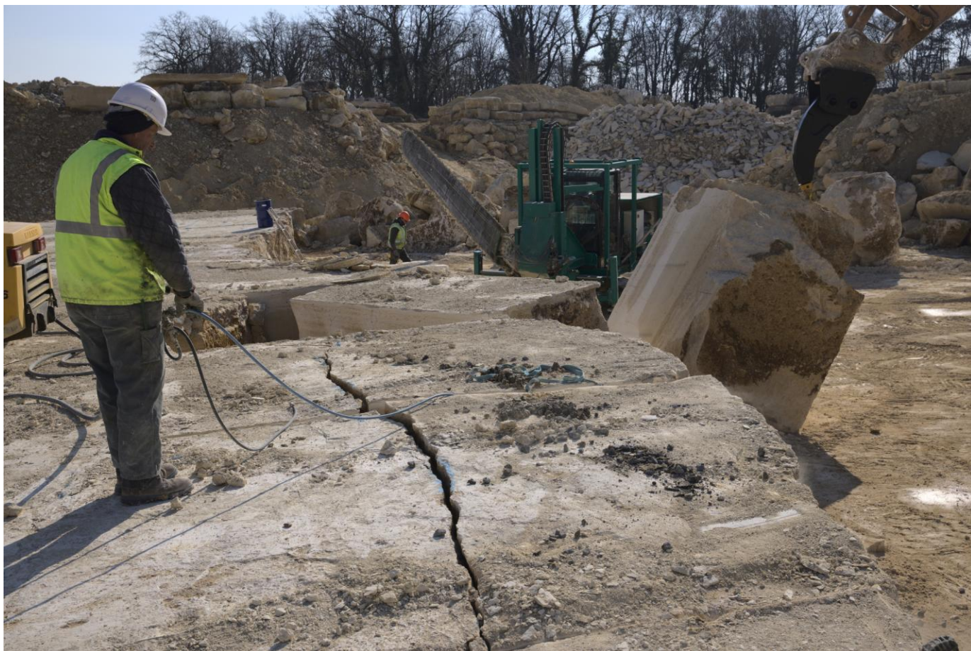
Au sein des carrières, les pierres sélectionnées sont débitées selon les besoins du chantier © Patrick Zachmann/Magnum Photos
