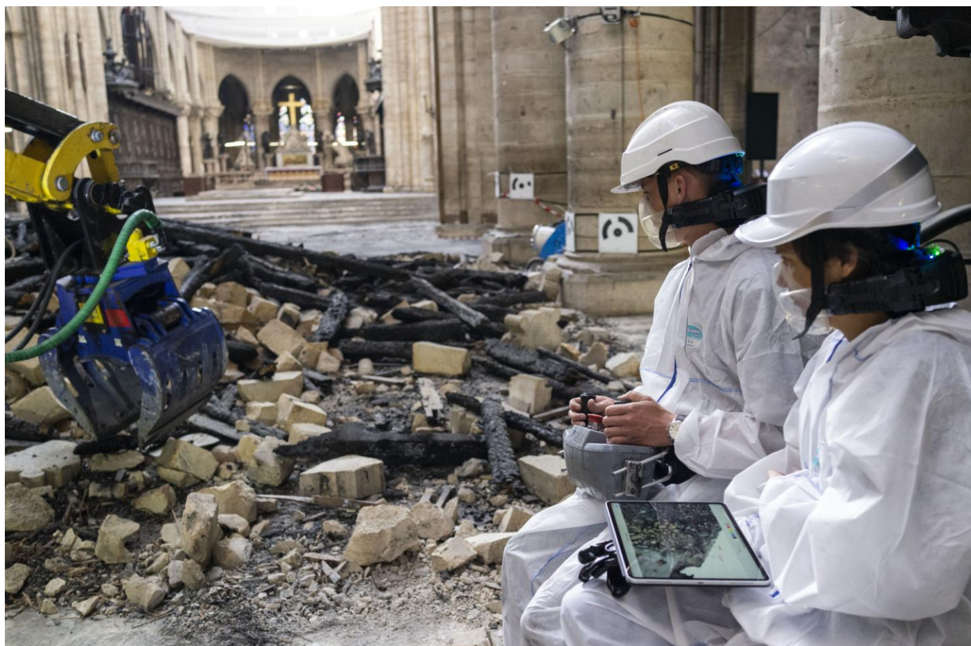
Déblaiement de vestiges de l'incendie à l'aide de robots télécommandés © Patrick Zachmann/Magnum Photos
