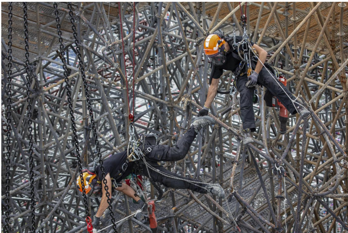
A l'aide d'une scie-sabre, les cordistes démontent l'échafaudage sinistré pièce par pièce © Patrick Zachmann/Magnum Photos
