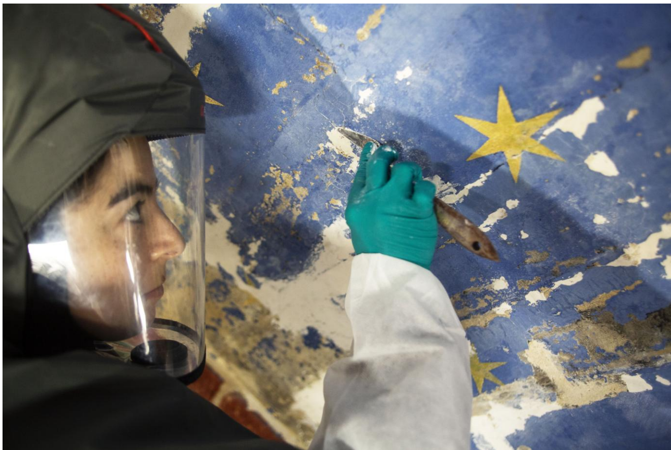
Pose de mastic sur les lacunes de la voûte de la chapelle Saint-Ferdinand par une restauratrice de peintures murales
