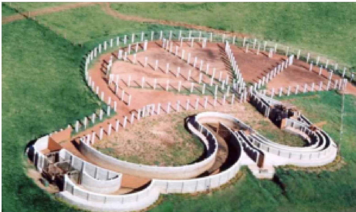
Recinto per bestiame utilizzando le linee guida di progettazione di Temple Grandin (immagine di Roberto E. de A.)
